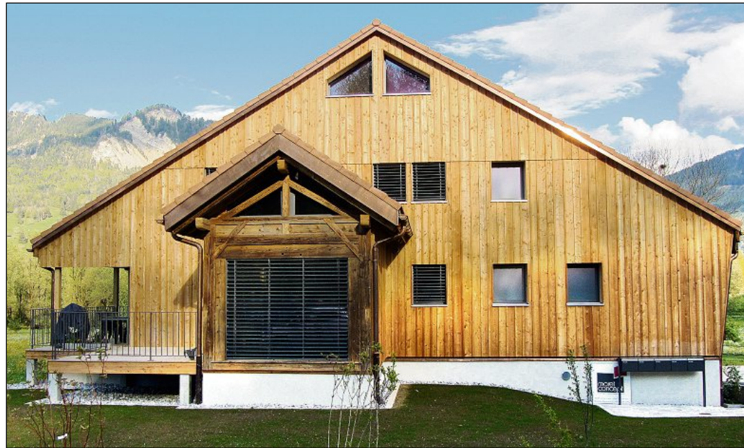
A Morlon, le conducteur de travaux Thierry Moret a supervisé la transformation de cette grange, qui abrite aujourd'hui quatre appartements dont trois triplex. L'ossature d'origine a été conservée. DR
